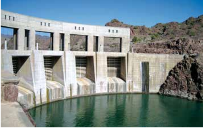
Parker-Damm und Zufahrtsstraßen, USA
